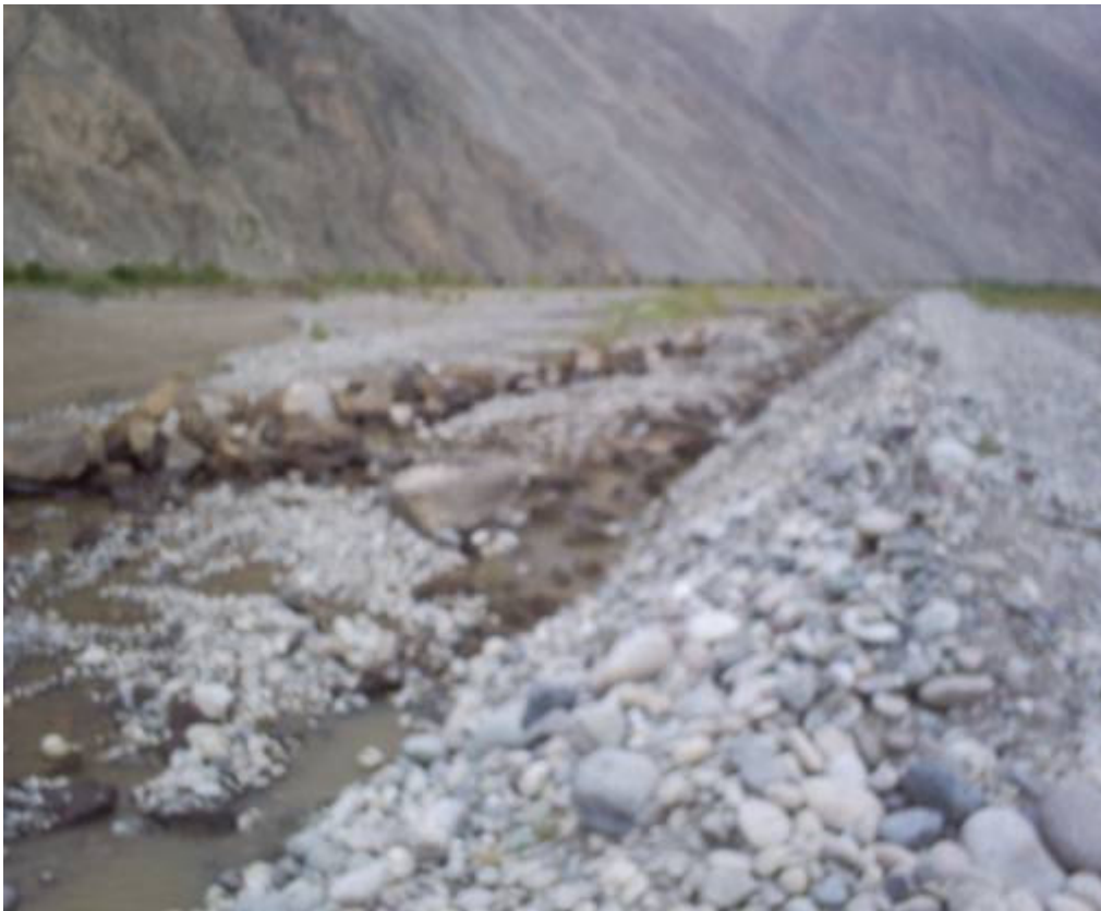
Construcción de Dique Enrocado Sector Anchalo Huacan-Valle de Ocoña
