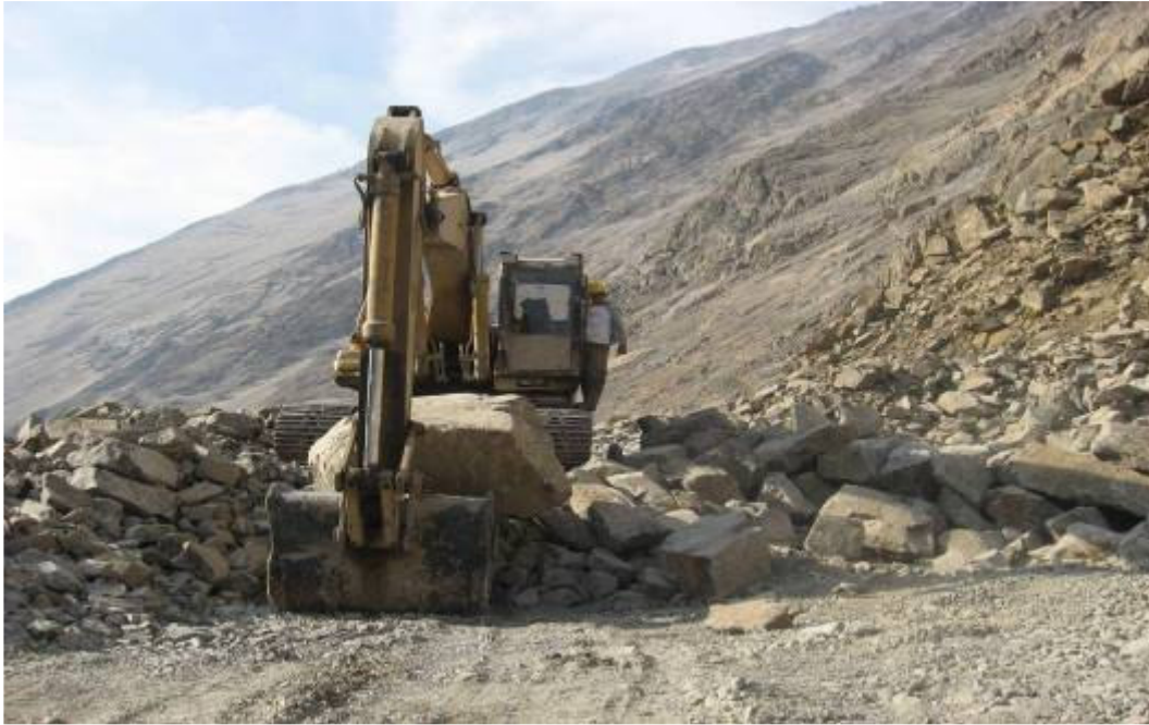
Construcción de Defensa Ribereña Sector Jayhuiche - Valle de Ocoña
