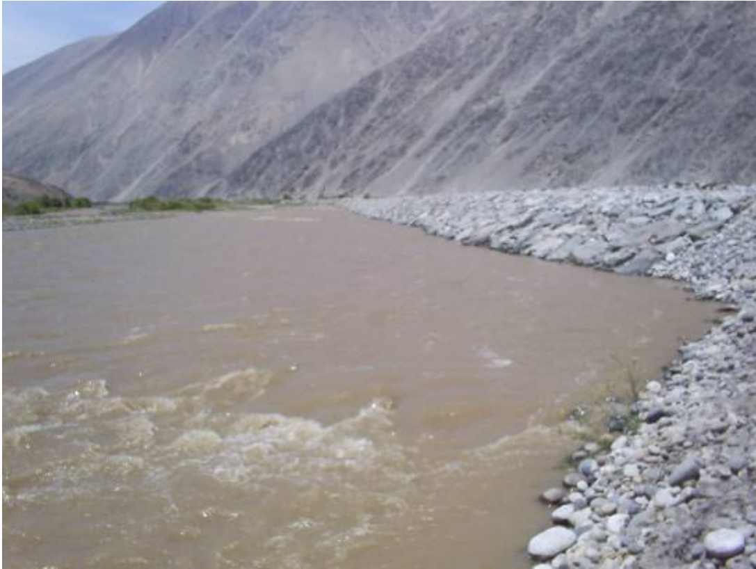
Construcción de Dique Enrocado Sector Anchalo Huacan-Valle de Ocoña
